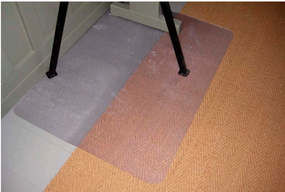
Bild kyrka 2.4: Plastskivan under lusbäraren ger inget brandskydd!
