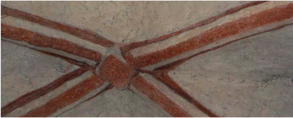
Bild kyrka 2.3: Svärtning i valven.
