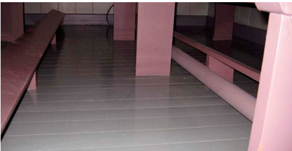
Bild kyrka 5.3: Radiatorer under bänkarna.
