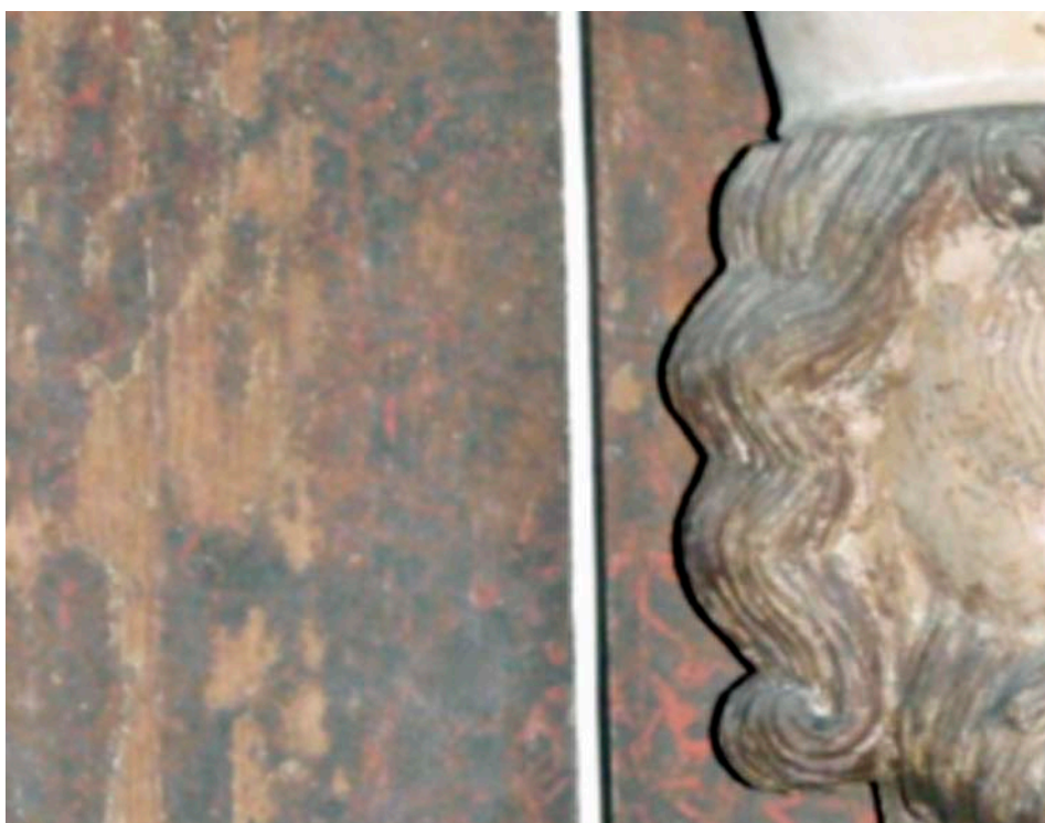
Bild kyrka 4.2: Krympsprickor och omfattande färgflagning.
