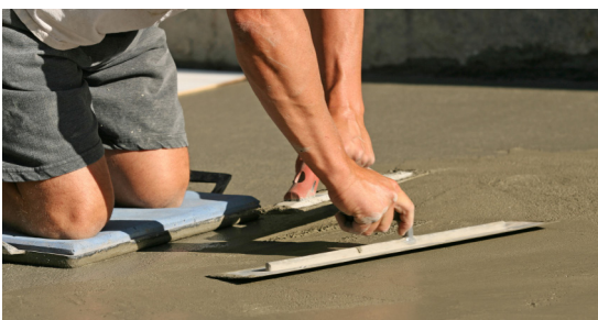
FIGUR 4. Avjämning av golv.
