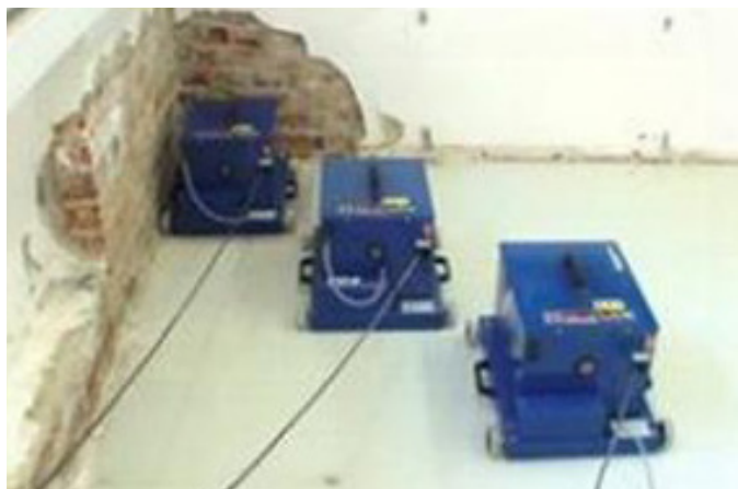
FIGUR 15. Torkning av betonggolv med mikrovågsteknik.
