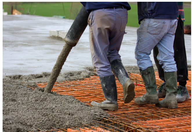
FIGUR 3. Platsgjutning av betong.
