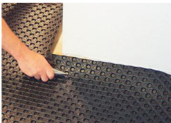
FIGUR 18. Distansmatta för mekaniskt ventilerade golv (Gustavsson, 2006)
