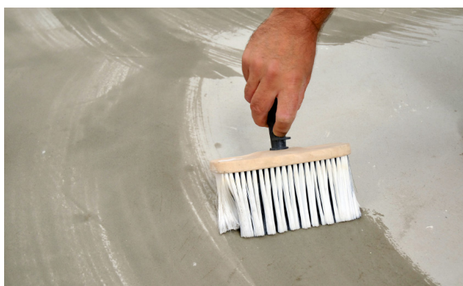
FIGUR 16. En fuktspärr förhindrar fukttransporten upp genom betongytan.
