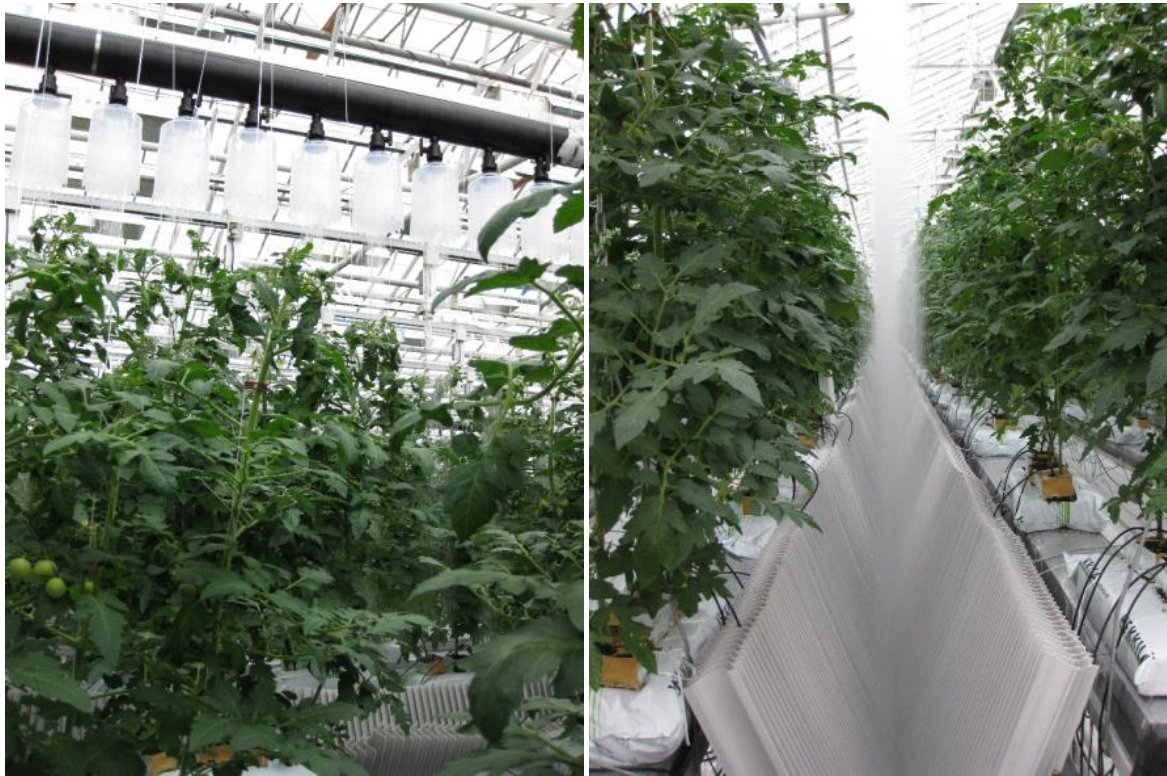
Figur 3 Inneenhetens munstycken (vänster) och vattenseparerande plastprofiler (höger)
